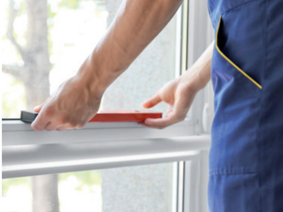
garantizar la equiparación a las prestaciones de la ventana. Se debe poner especial atención para que el montaje de la ventana no cree puentes térmicos ni filtraciones a través del hueco de ventana, es decir, que la ventana continúe manteniendo el aislamiento del cerramiento entre el interior y el exterior.
